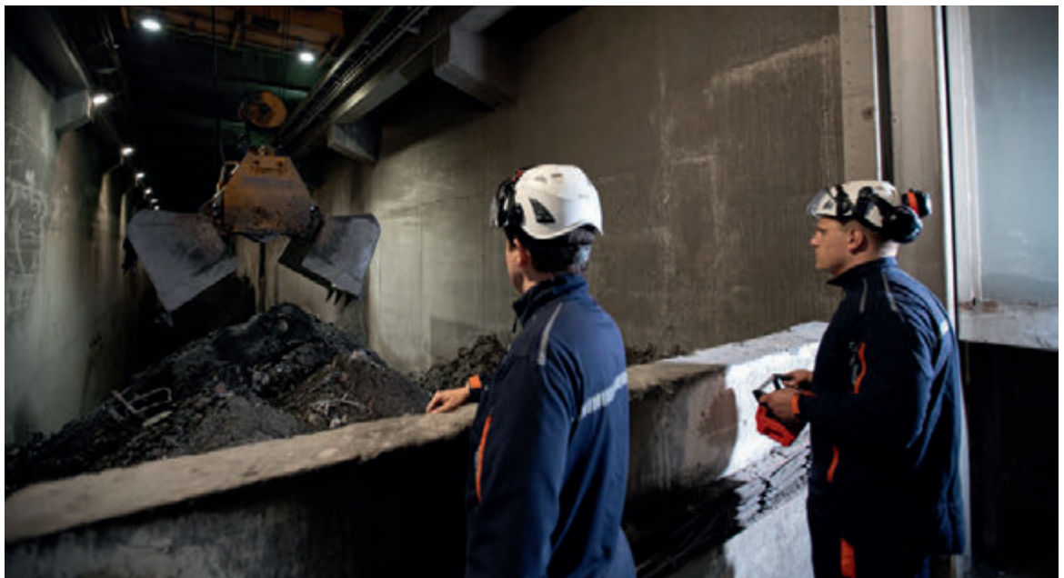
Schlackenbunker, Quelle: EEW
