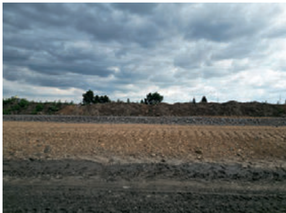
Tragschichten mit EBV-Material, Quelle: Breer
