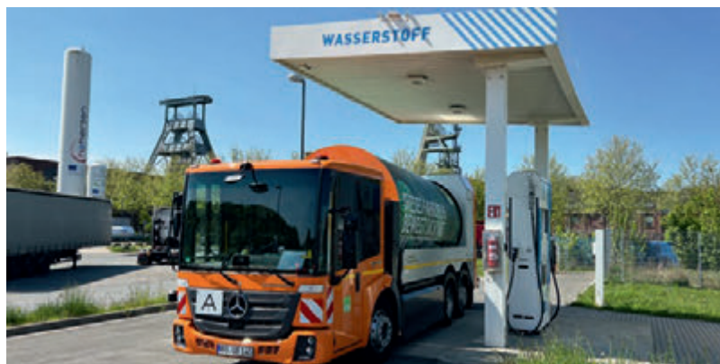
Wasserstofftankstelle, Quelle FAUN
