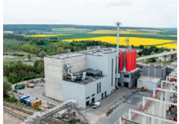
Mono-Klärschlammverbrennungsanlage, Quelle: EEW
