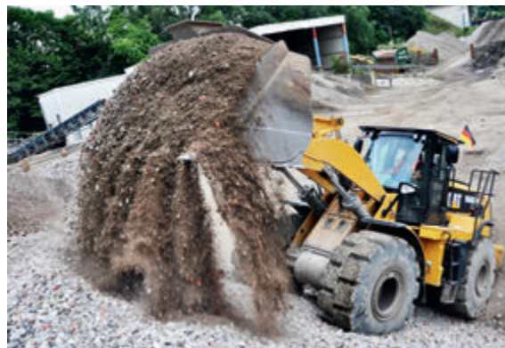
Baustoffrecyclat zur Halde schichten, Quelle: Breer
