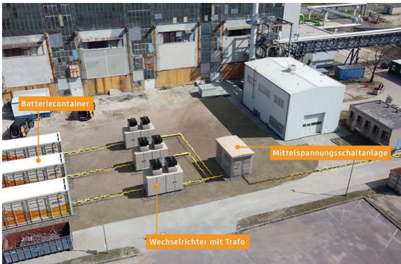
Visualisierung des Batteriespeichers in Premnitz, Quelle: EEW
