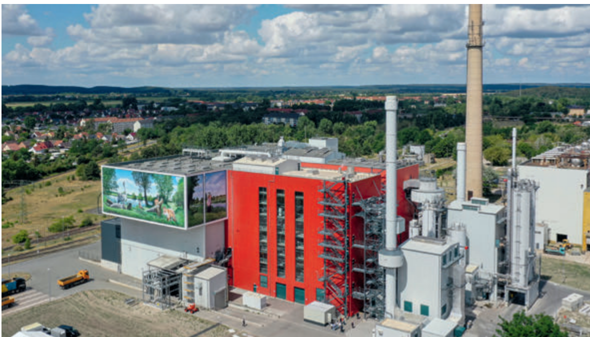
MVA Premnitz, Quelle: eew
