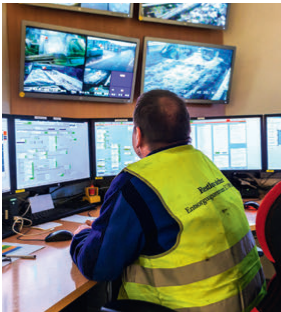
Zugangskontrolle, Quelle: Newwaste
