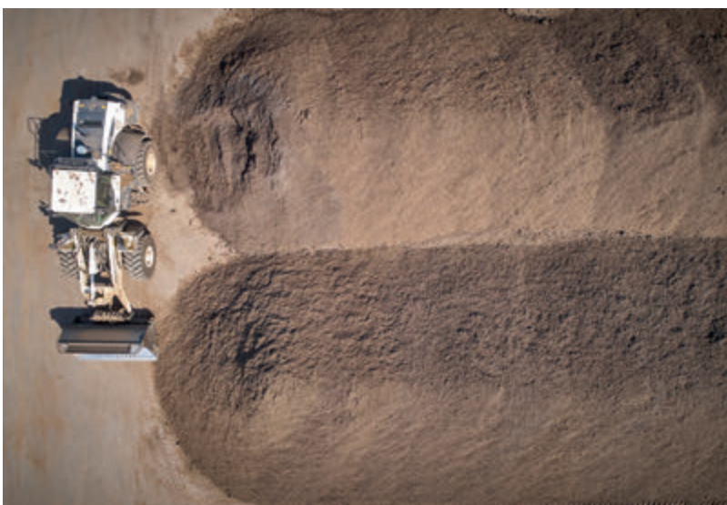
Werk zur Altholzaufbereitung, Quelle: Reiling
