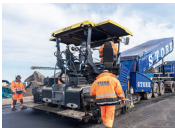
Mineralgemisch beim Deponiebau, Quelle: Stork
