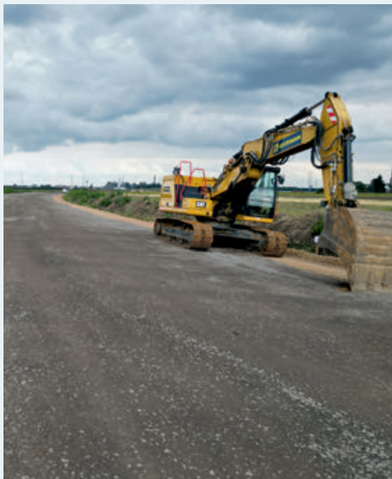
Straßenbau, Quelle: Phoenix
