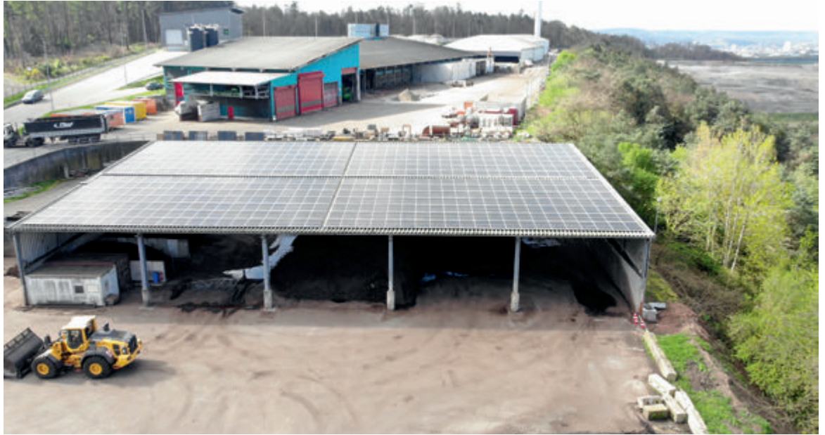
Energiegewinnung mit PV-Anlage, Quelle: ZAK
