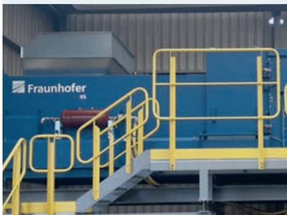
Danger Sort in der Lobbe Sortieranlage in Iserlohn, Quelle: Lobbe 139
