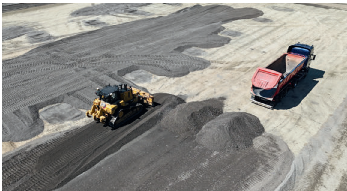
Frostschuttschicht, Quelle: Blue Phoenix
