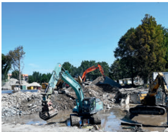
Aufbruch der Fundamente, Quelle: Breer
