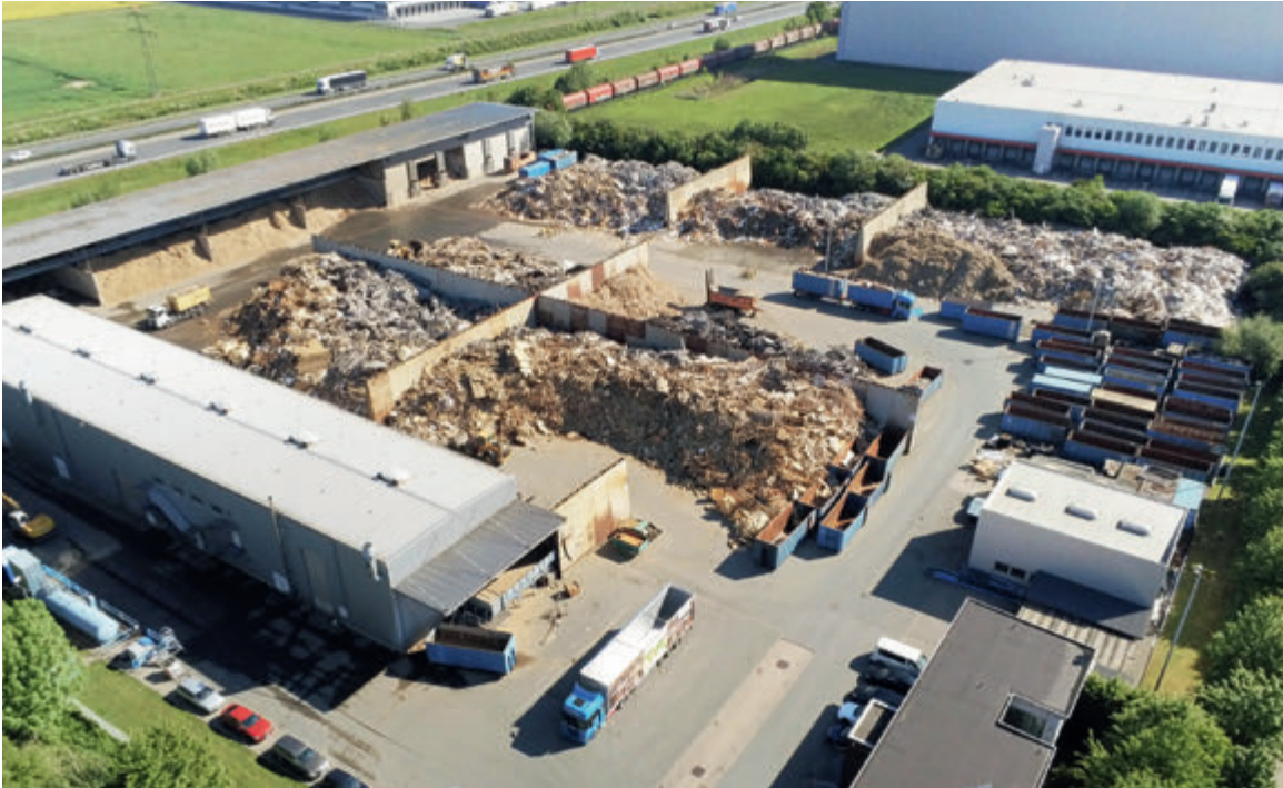
Werk zur Altholzaufbereitung, Quelle: Reiling
