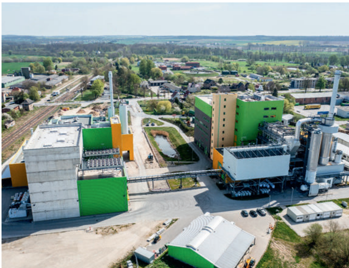
Der EEW-Standort Stavenhagen mit Klärschlamm-Monoverbrennungsanlage (li.) und Ersatzbrennstoff-Heizkraftwerk (re.), Quelle: EEW
