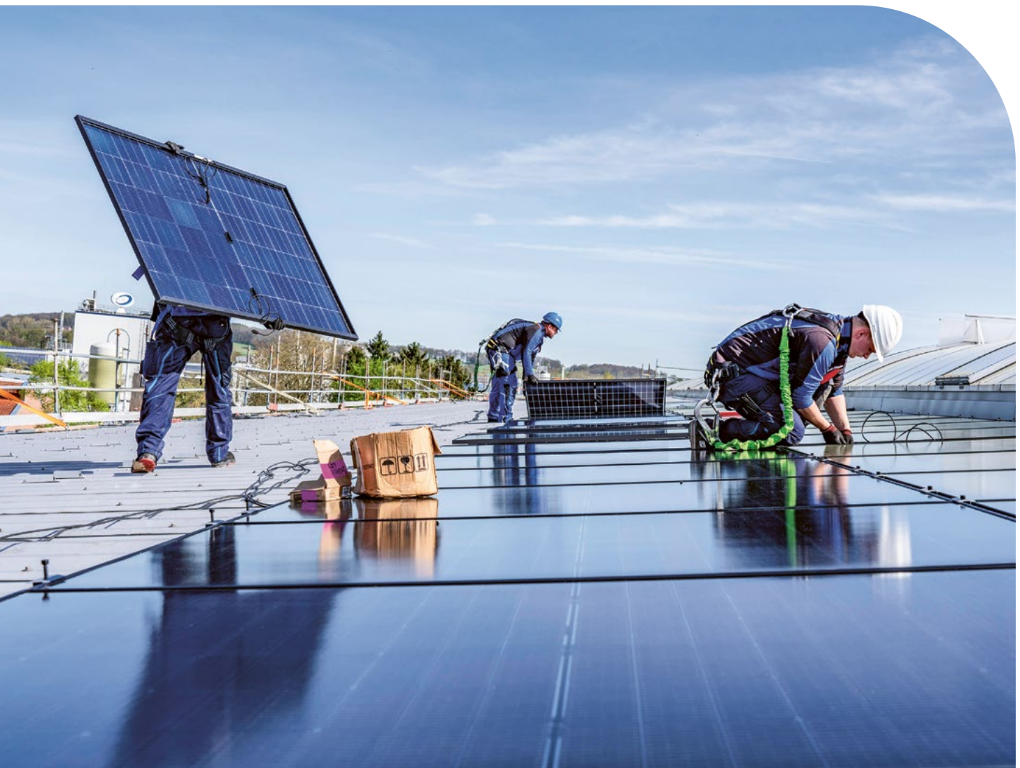
Montage von Solarmodulen auf dem Dach eines Gewerbebetriebs in Nordrhein-Westfalen (Teilmarkt „Umweltfreundliche Energiewandlung, -transport und -speicherung“).
