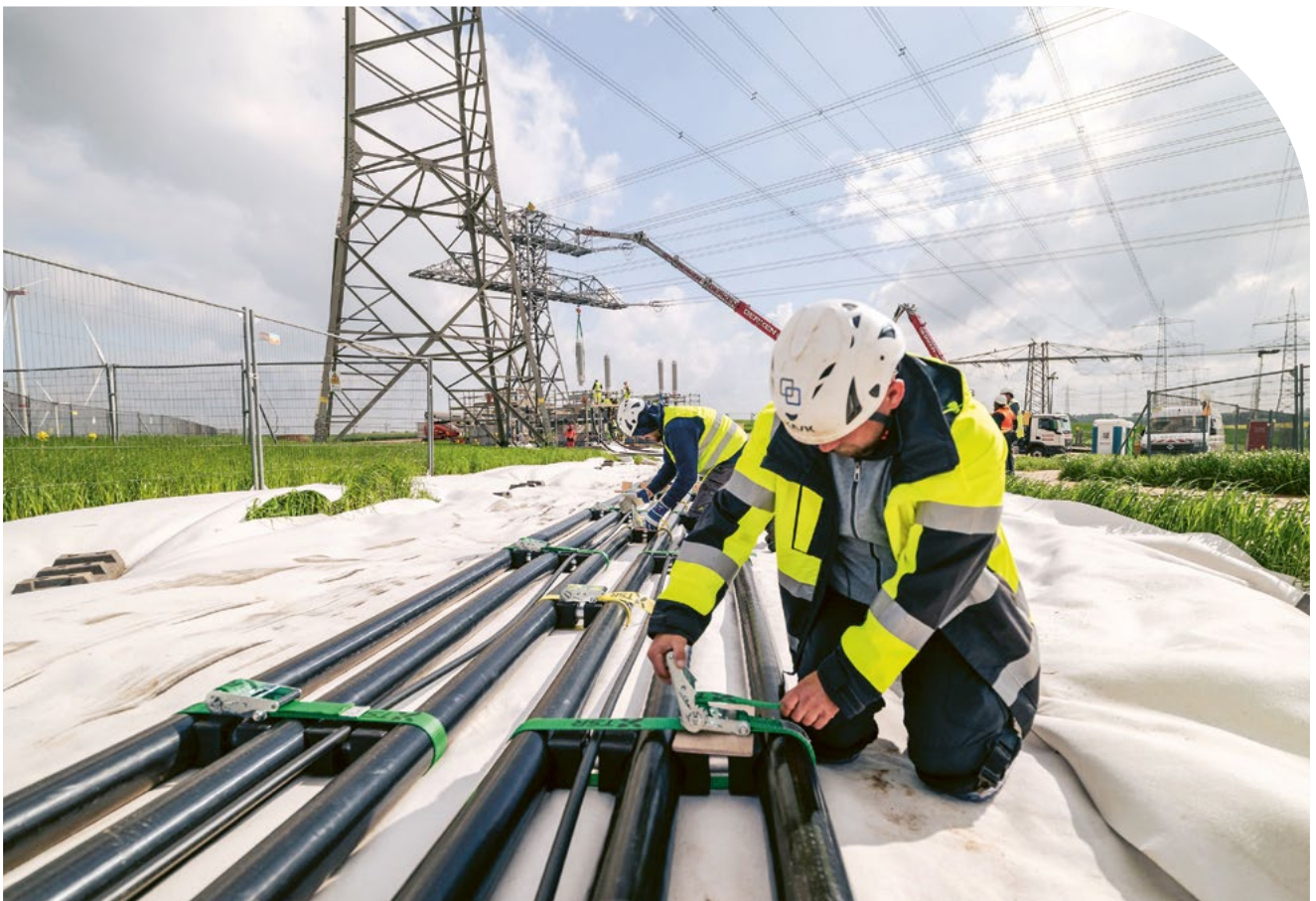
Bauplatz im Rheinland: Amprion (Dortmund) baut und betreibt den nordrhein-westfälischen Teil des neuen 380-KV-Ultranets zwischen Osterath in Nordrhein-Westfalen und Philippsburg in Baden-Württemberg (Teilmarkt „Umweltfreundliche Energiewandlung, -transport und -speicherung“).
