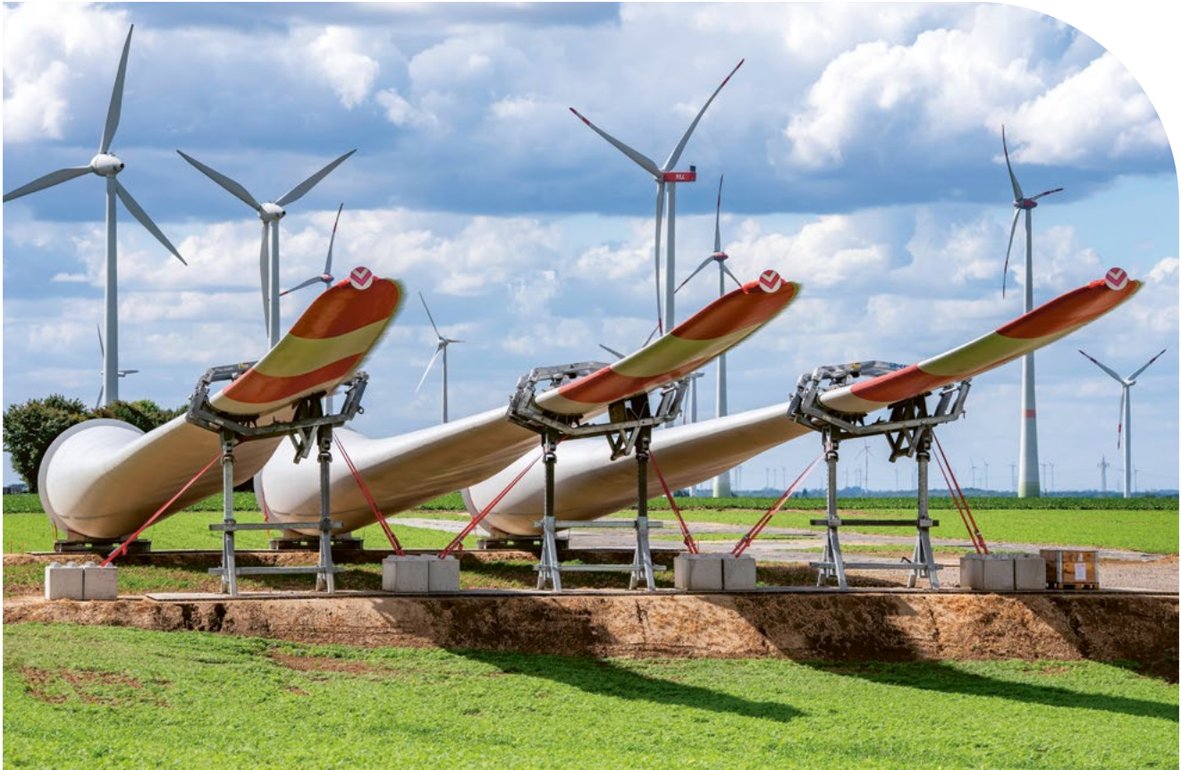
Erkelenz: Baustelle für die Erweiterung des Windparks Lövenich, 2025 (Teilmarkt „Umweltfreundliche Energiewandlung, -transport und -speicherung“)
