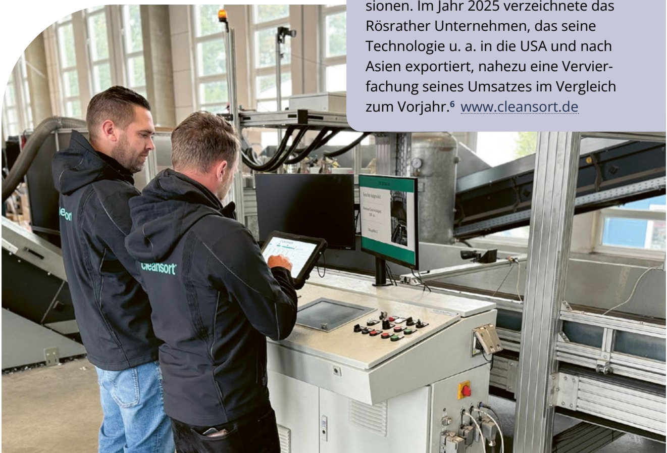
Rösrath: Sortieranlage der Cleansort GmbH (Teilmarkt „Kreislaufwirtschaft“)
